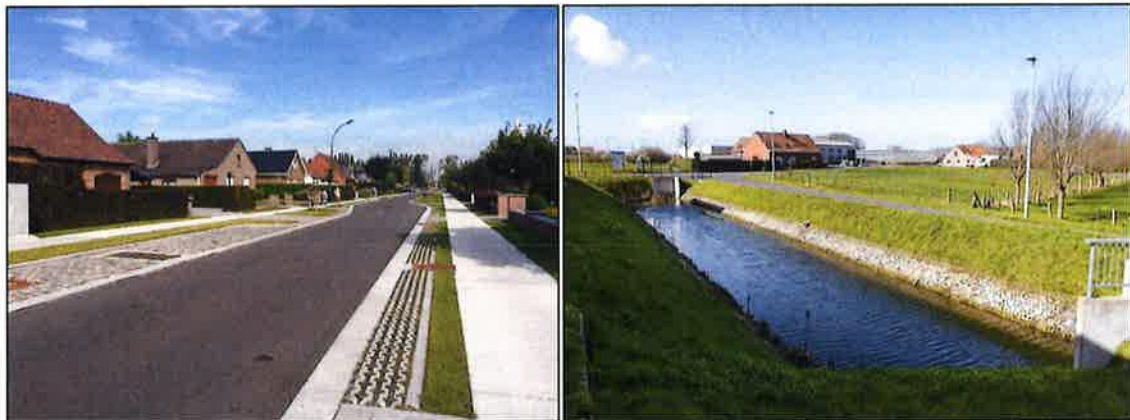
Figuur 65: Links: Lokale infiltratie wegverharding en fietspad. Rechts: Infiltratiebekken.
