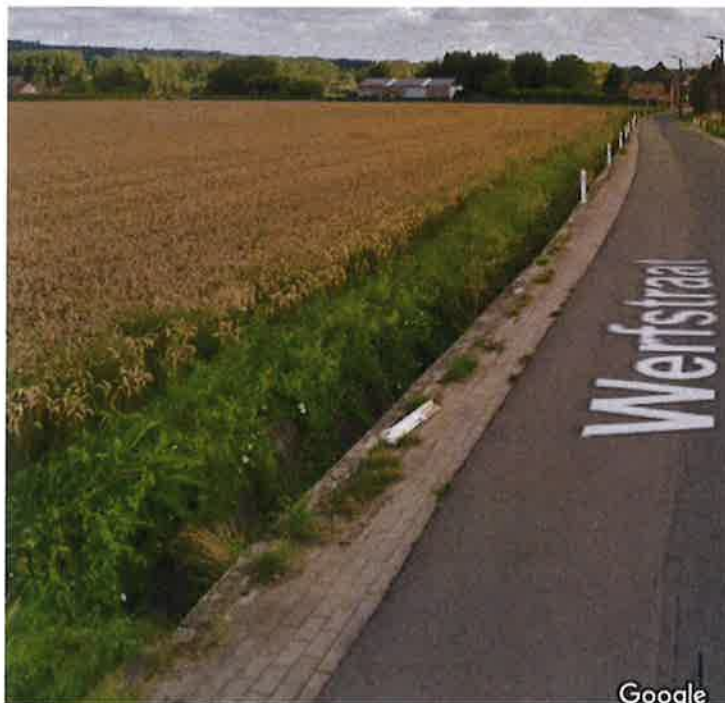
Grachten in betonelementen langs de Werfstraat worden beter doorlatend aangelegd.
