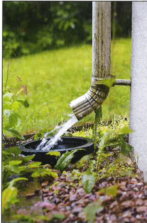
Figuur 63: Afkoppelen dakafvoer van het afvoerstelsel.
